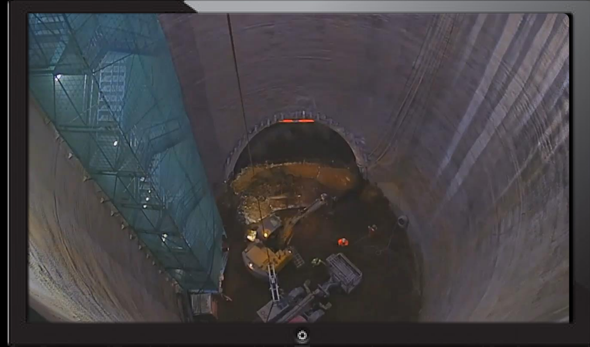
Construcción de Extensión de Línea 2 durante años 2020
