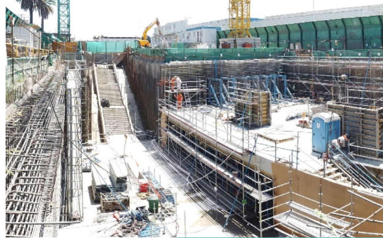
Trabajos en Estación Lo Cruzat
