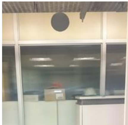
Imagen 3. Sala 2. Pérdidas de frío debido al uso de vidrio, tabiquería ligera y cierre deficiente.
