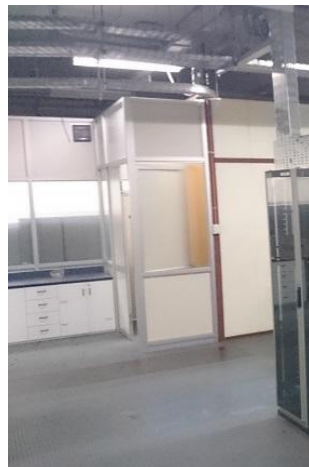
Imagen 4. Sala 3. Pérdidas de frío debido al uso de vidrio, tabiquería ligera.
