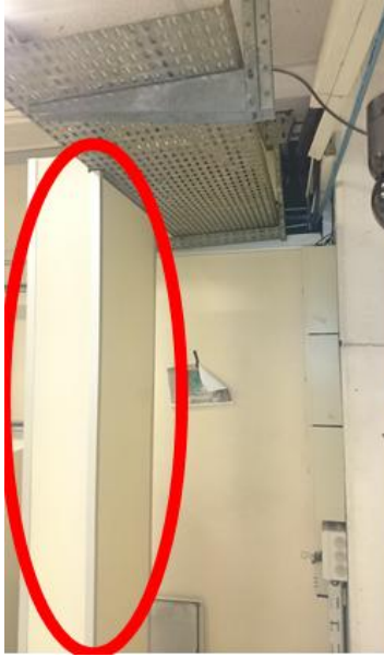
Imagen 8. Sala 2. Cierre y sellado de 1era bandeja con tabiquería ligera.
