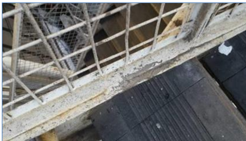
Imagen a sector a reparar con soldadura.
