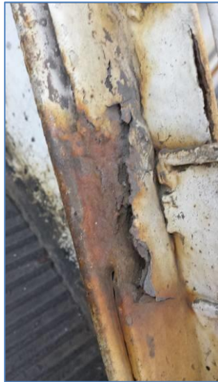
Imagen a sector a reparar con soldadura.
