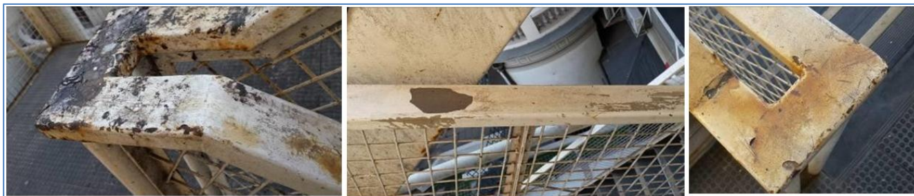
Imagen a sector a reparar con soldadura.
