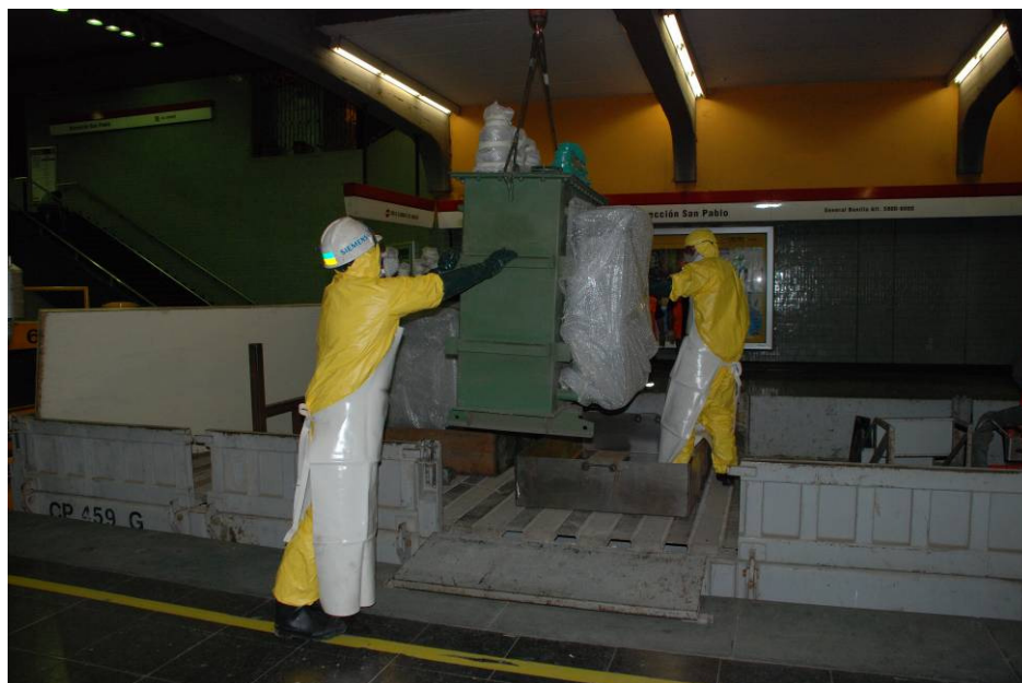
Figura 38. Transporte de transformador con PCB vía Trackmobil
