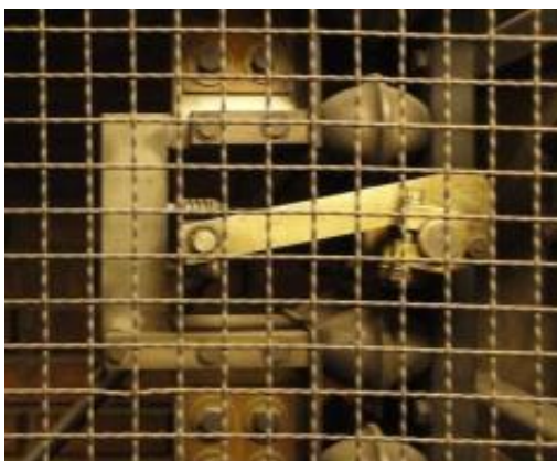
Fig. 3. Seccionador de Aislamiento Automático, SAA. SER L1 y L2.
