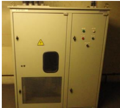
Fig. 4. Seccionador de Aislamiento Automático, SAA. SER L5.
