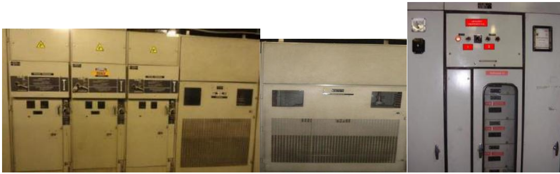
Figura 10. Celdas Medias Tensión, Transformador, Tablero preferencial Tramo1 L5.
