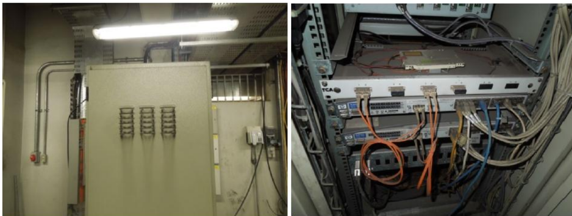
Figura 13. Registro visual tomado por Consultor, donde se muestra la suciedad en el exterior e interior de los armarios de los sistemas que soportan la operación.
