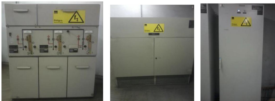
Figura 5. Celdas Medias Tensión, Transformador, Tablero preferencial Tramo2 L1
