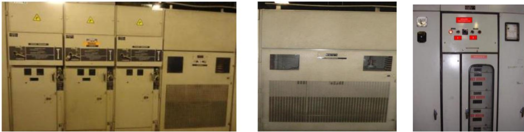
Figura 4. Celdas Medias Tensión, Transformador, Tablero preferencial Tramo1 L1
