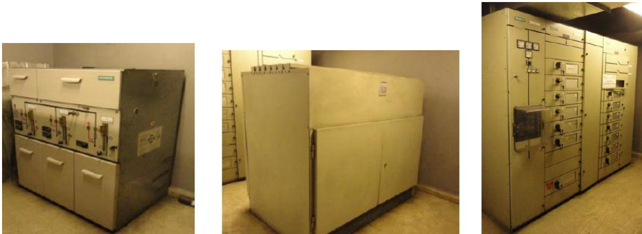
Figura 7. Celdas Medias Tensión, Transformador, Tablero preferencial Tramo2 L2
