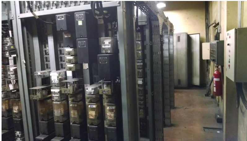
Figura 1. Equipamiento de señalización en Sala de Corrientes Débiles L1.
