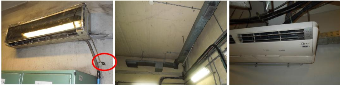
Figura 12. Equipos de aire acondicionado desconectados, salas con sistemas de ventilación no operativa, sala con equipos de aire acondicionado operativo.
