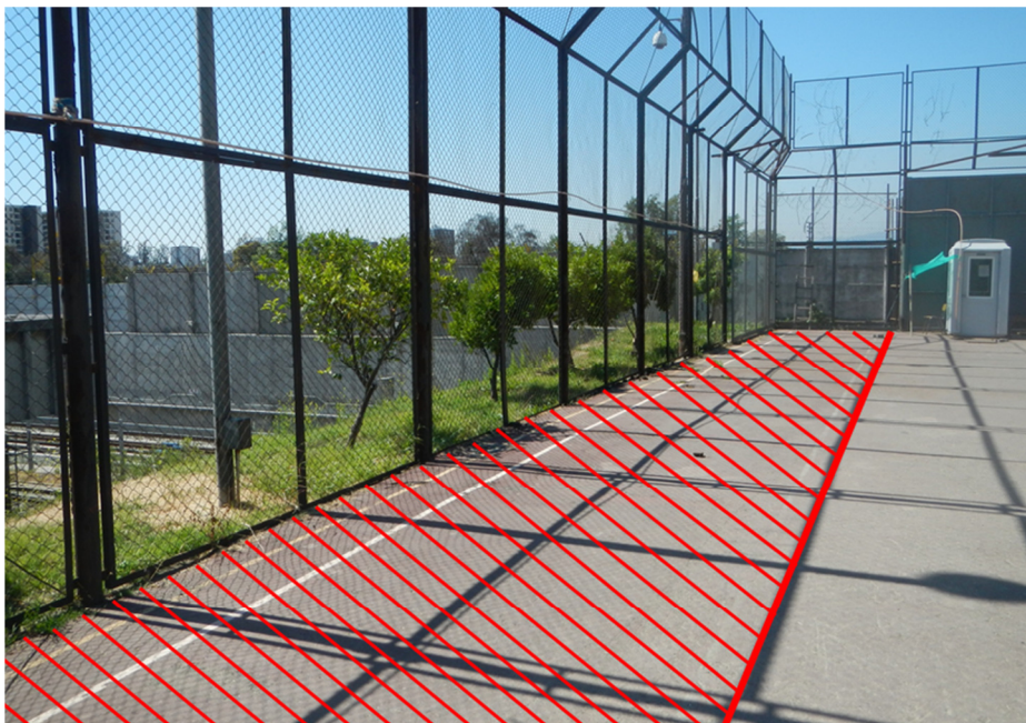
Figura 2.3: Representación del área de la superficie a picar (radier)
