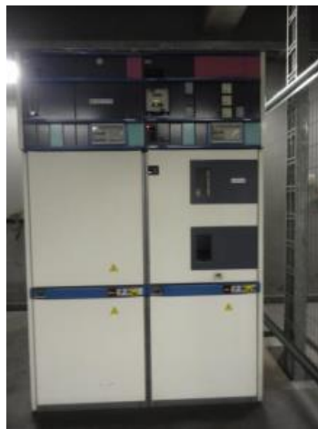
Fig. 1. Celda media tensión Alstom, SER L5 tramo 1.
