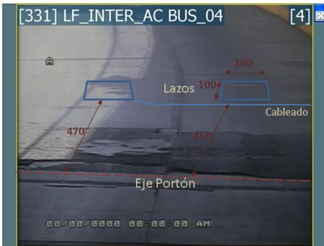
FOTO 05: Lazos de Control de Tráfico en pavimento que deben ser repuestos.
