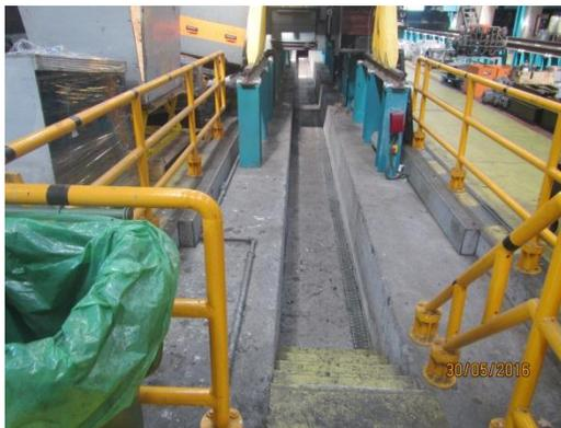
3. Para la limpieza de superficie de ambos fosos se apreció en visita a terreno que presentan contaminación con hidrocarburo, para lo que la preparación de superficie con hidrolavadora no sería suficiente, frente a esto se sugiere un escarificado del foso.
