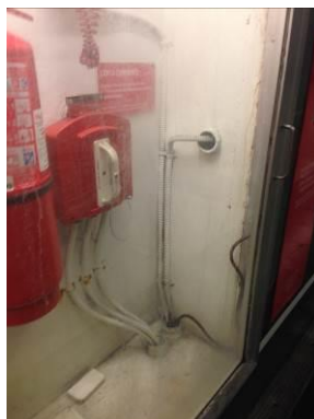
Imagen 2. Cables superficiales en nichos de emergencia
